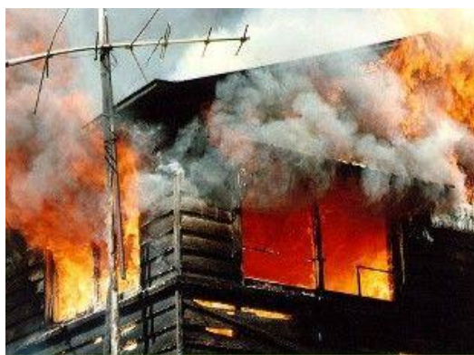
b. Structură portantă din lemn supusă acțiunii focului
