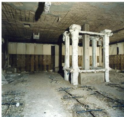
Figura 7.7 Structură portantă din beton armat supusă acțiunii focului
